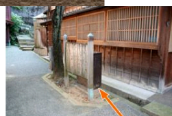
沿線に配慮し、看板の後ろに地上機器を設置
