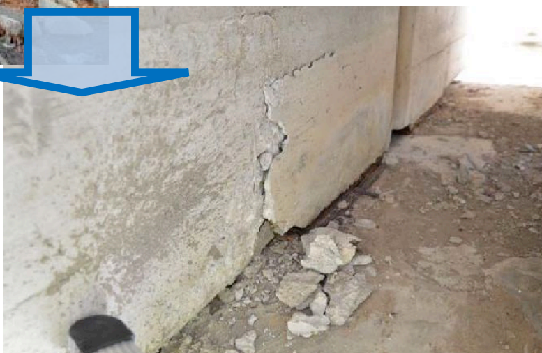
〈桁ひび割れ状況〉
