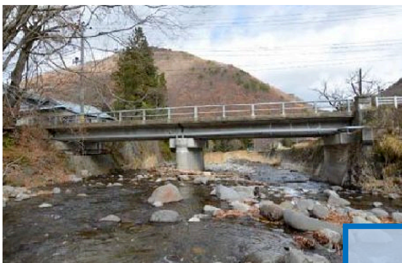
〈上流から望む橋梁全景〉
